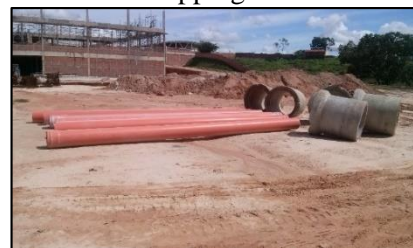
Fig. 4b – Material utilizado na tubulação de água do Shopping Caxias
