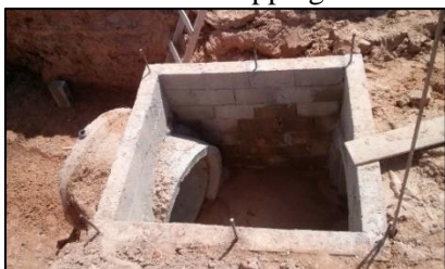
Fig. 4a – Caixa de Armazenamento do sistema hidráulico do shopping Caxias
