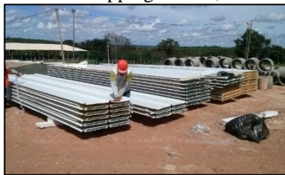
Fig. 3a – Telhas Termorooft utilizadas na cobertura do Shopping Caxias, Caxias-MA
